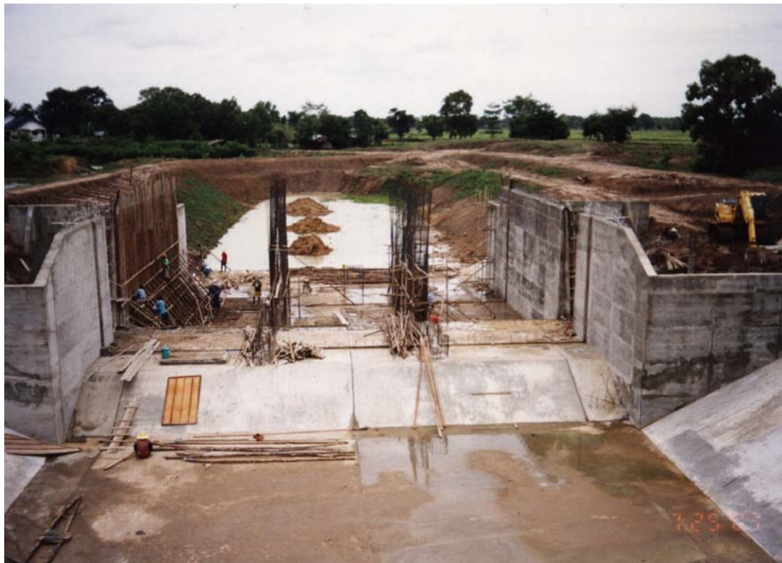
รูปภาพแสดงโครงการเสริมเหล็กฝาย มข.
